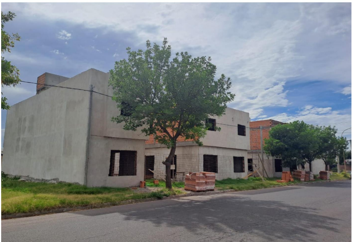
VISTA FRENTE DE LA OBRA
